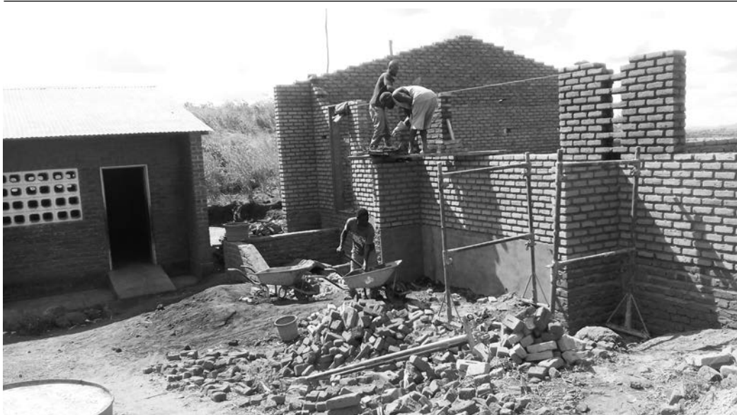
Klaslokalen in aanbouw Lobeni
