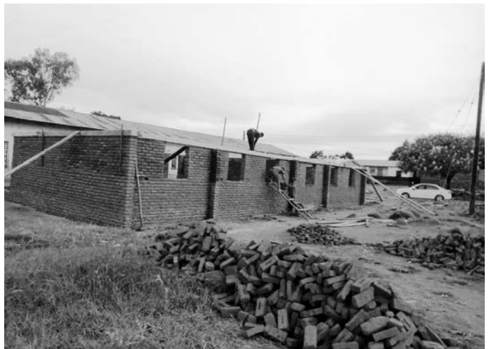
Bouw klaslokalen Nyambalo
