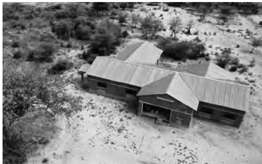
Nguluwe kliniek in aanbouw
